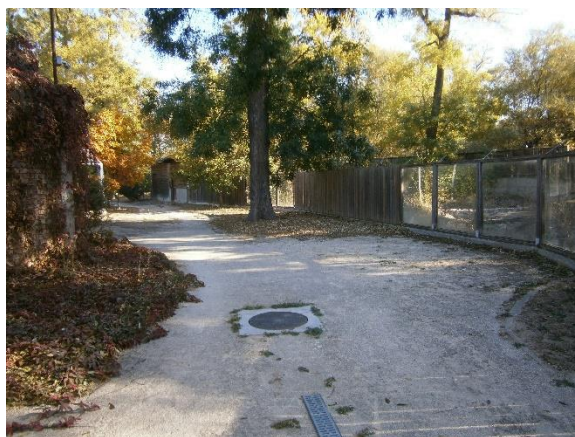
Водосъбирателна шахта и капак на канализация (ориг.)
